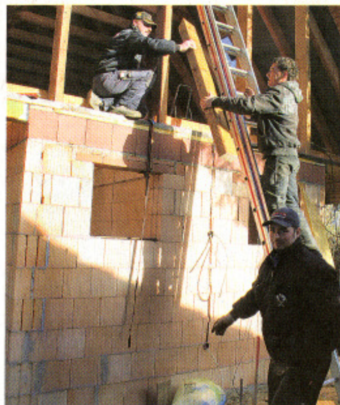
Die Mannen der Dachdeckerei Krumm bauen ebenfalls am neuen Sanitärgebäude der Kanumühle mit. Foto: Dana Seiler
